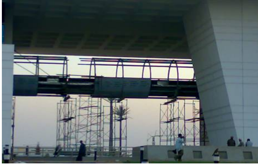
اختبار تحميل كوبرى للمشاة
